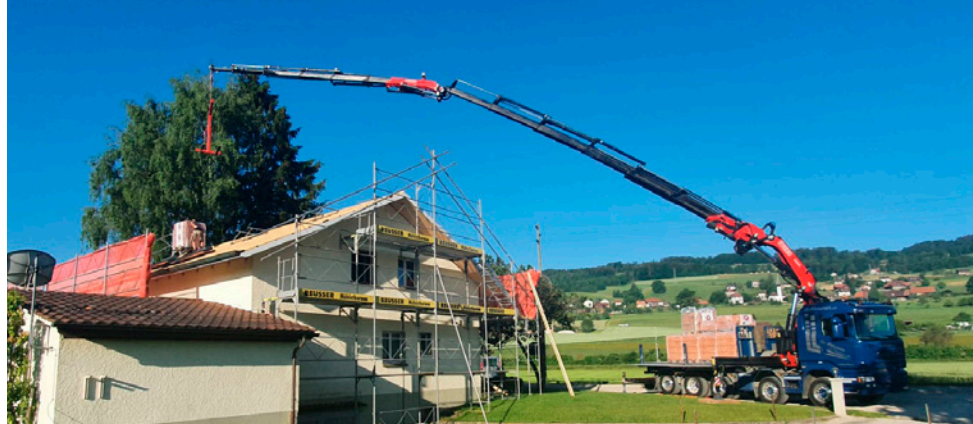
Kran mit 33 m Reichweite beim Ziegelablad auf ein Dach.
