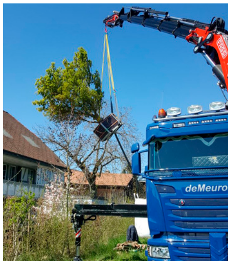
Einbringen von Pflanzen auf einer Gartenbau-Baustelle.
