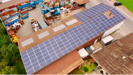
*Gasser-Balsiger betreibt seit 2018 ein fast 300 m<sup>2</sup> grosses Solardach mit 50 kW Maximalleistung und versorgt sich übers ganze Jahr gesehen zu 100% mit eigenem Strom. Für das Recycling von Solarzellen stehen übrigens bereits Lösungen bereit, finanziell abgesichert durch eine vorgezogene Recyclinggebühr.*
