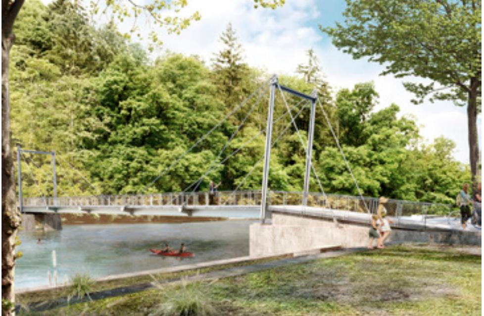
Während die alte Brücke eine Fahrbahnbreite von 2,7 m aufweist, soll die neue (hier eine Visualisierung) total 4,4 m breit werden, aber ebenfalls nur einspurig befahrbar sein und max. 3,5 t tragen; somit wird mehr Platz für Fussgänger und Velofahrer bleiben.
