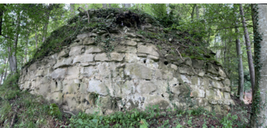
Teile der westlichen Stützmauer.
