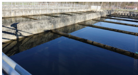
Im Nachklärbecken sinkt der Belebtschlamm (Bakterienmasse) auf den Boden und wird abgepumpt. Das gereinigte Wasser darüber gelangt in die Aare.
