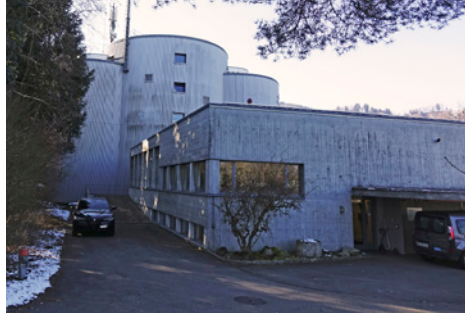
Betriebsgebäude und die zwei Faultürme. Hier bildet sich aus dem Klärschlamm methanhaltiges Gas, das zwei strom- und wärme produzierende Blockheizkraftwerke speist.
